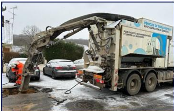
Réparation d'une fuite à l'aspiratrice sur Etréchy
